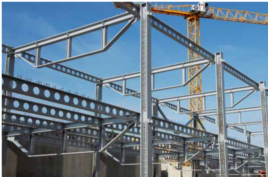
La Maison de la Paix, à Genève (photo du haut), et la structure métallique de B.Braun à Crissier.
