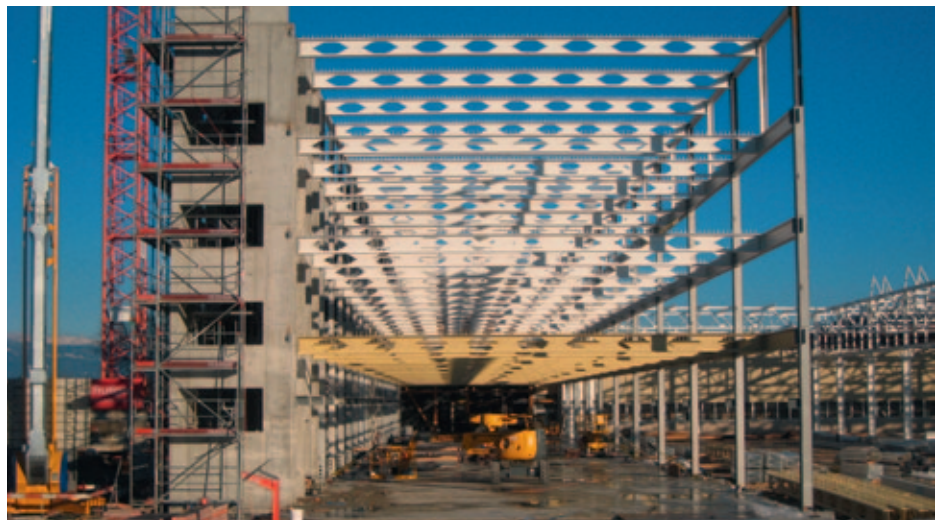
Nouveaux bâtiment de Bobst SA à Mex: optimisation des structures aussi pour la sécurité incendie (exigence R60).
